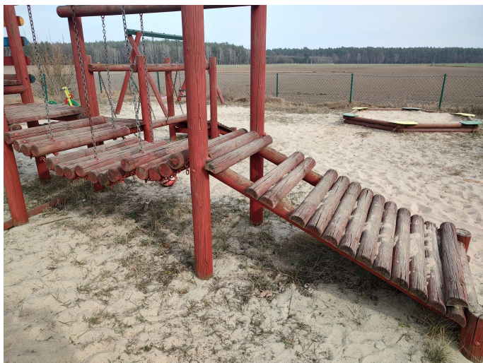
f) wymiana brakujących elementów drewnianych (belek) na pomoście w drewnianym domku.
